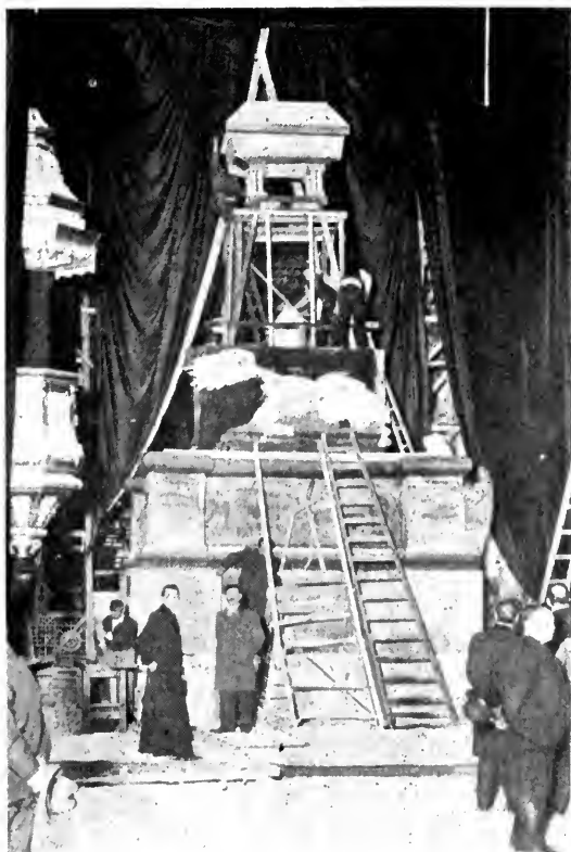
La construcción del catafalco
