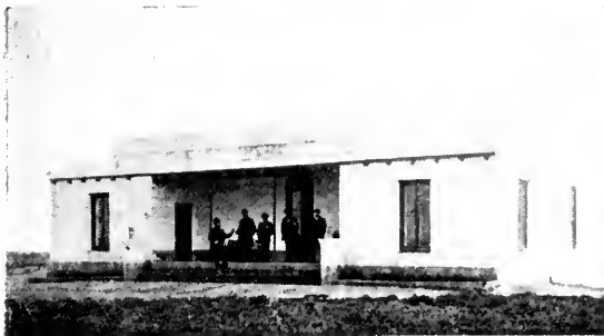
Edificio de la administración
