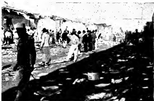
El incendio á las 11 a. m.
