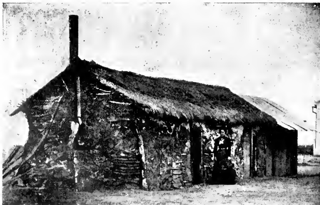
Antiguo rancho de la Remonta
