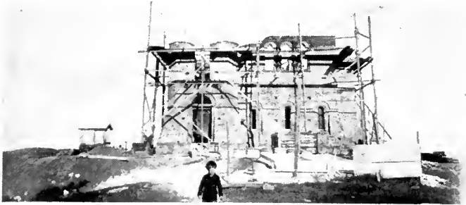
El edificio para tanque de aguas corrientes
