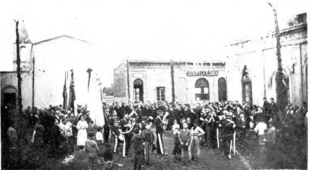
En el acto de la colocación de la placa con la nueva denominación
