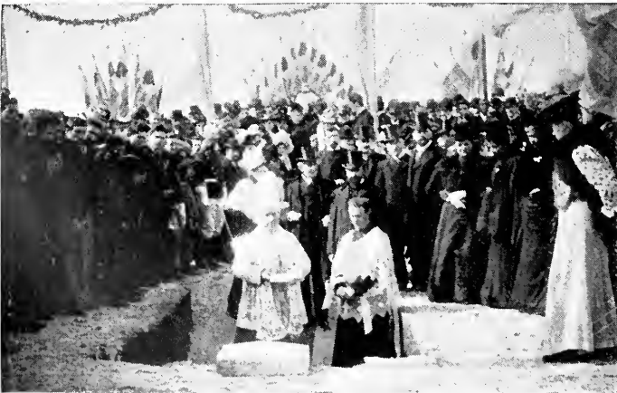
Bendición de la piedra fundamental
