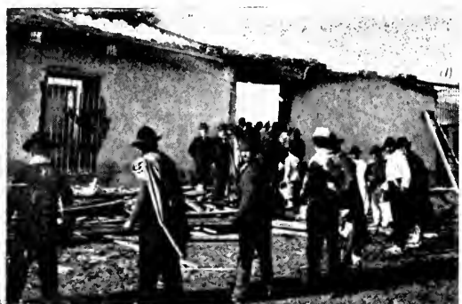
La parte por donde se cortó el edificio para aislar el fuego
