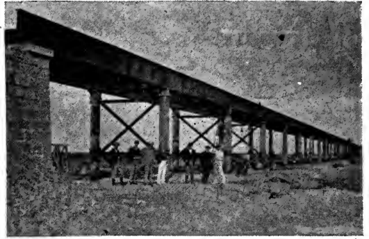
Viaducto de 2 kilómetros al Norte del puente principal
