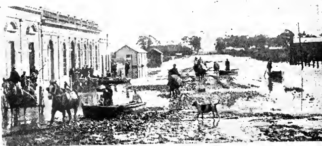
La calle Real, vista desde el edificio municipal
