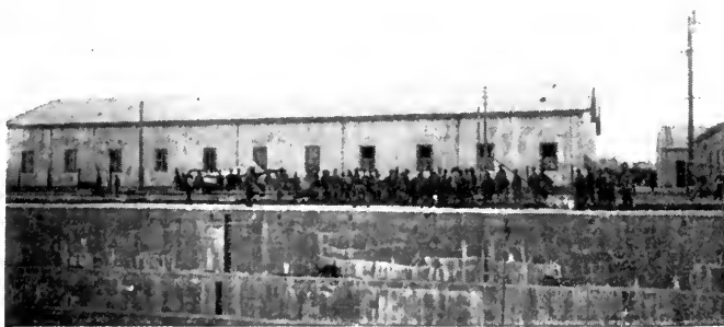
Edificio ocupado por la administración de los talleres
