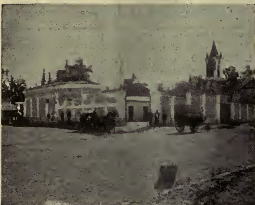
ESTACIÓN DE DESINFECCIÓN
