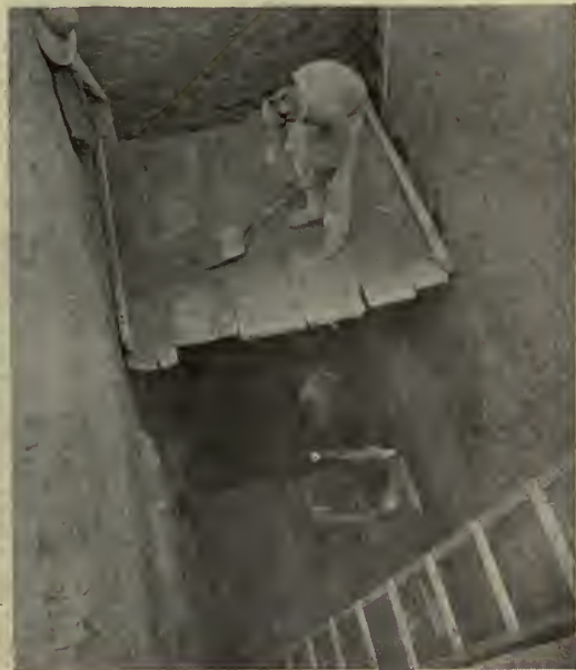
EXCAVACION DE LOS REGISTROS Y EXTRACCION DE TIERRA DEL TUNEL EN LAS OBRAS DE DESAGÜE
