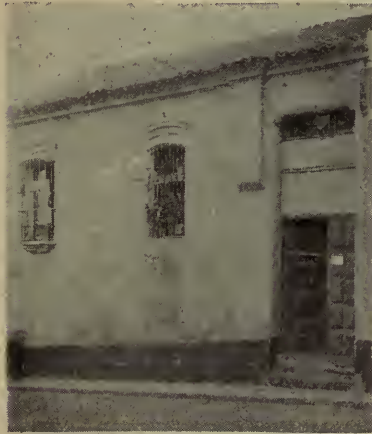
LO QUE QUEDA DE LA CASA DEL OIDOR TELECHEA. DES DE LA CUAL AMETRAL- LÓ LA TORRE DE SANTO DOMINGO EL CAPITÁN JOSÉ FORNAGUERAS
