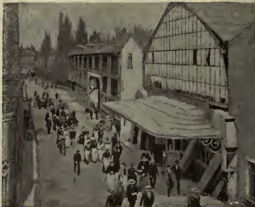
ALA PRINCIPAL DEL EDIFICIO ANTES DE LA EXPLOSIÓN
