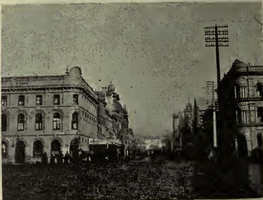
QUEEN STREET EN AUCKLAND (NUEVA ZELANDIA)
