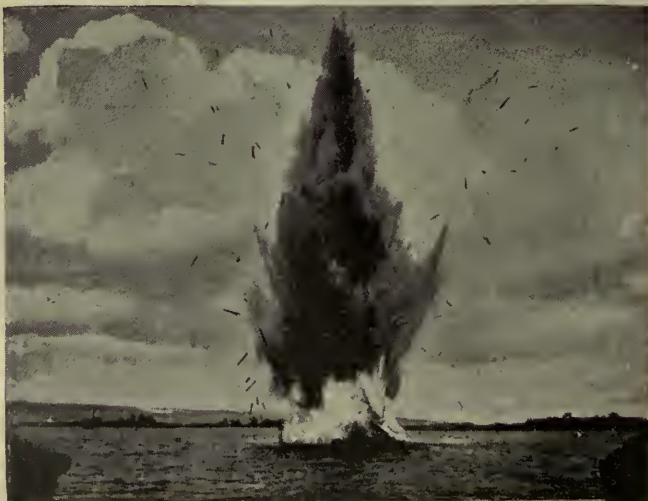
VOLADURA DE UN CASCO DE BUQUE VIEJO SUMERGIDO EN EL MAR
