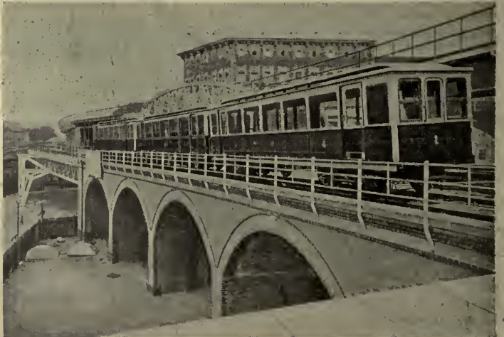
EL TRANVÍA ELÉCTRICO PASANDO UN PUENTE
