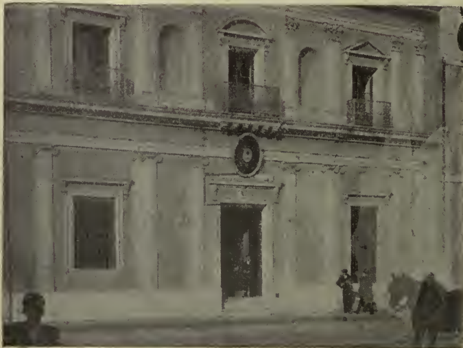
FRENTE DEL ACTUAL EDIFICIO DE LA UNIVERSIDAD
