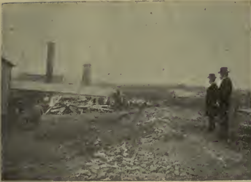
PABELLÓN DEL HORNO CREMATORIO, QUE ESTÁN INUTILIZANDO POR EL FUEGO
