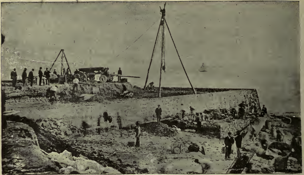
LOS TRABAJOS EN LA EXPLANADA DONDE SE HA COLOCADO LA PIEDRA FUNDAMENTAL DEL NUEVO PUERTO
