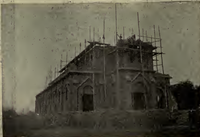
ESTADO DE LAS OBRAS DEL TEMPLO EN CONSTRUCCIÓN
