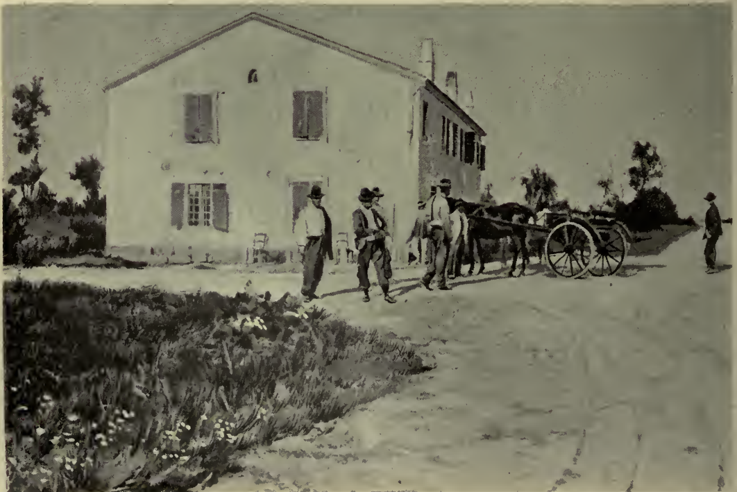
HOSTERÍA DISTANTE 50 METROS DEL PUENTE, A DONDE FUERON LLEVADOS LOS HERIDOS
