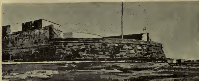
CASTILLO DE LA BRIGADA DE TORPEDISTAS (La caseta señalada con la letra A es en la que ocurrió la catástrofe)
