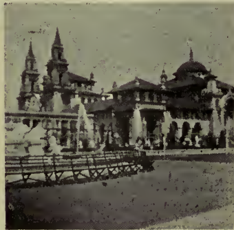
EDIFICIO DE LA MAQUINARIA
