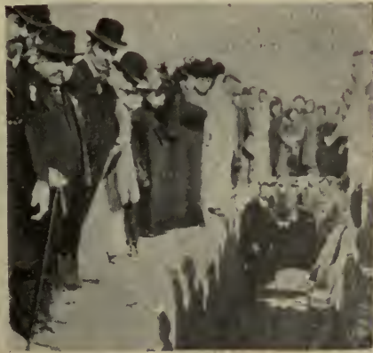
COLOCANDO LA PRIMERA PIEDRA
