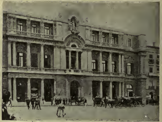
LA FACHADA MODERNA DE LA BOLSA
