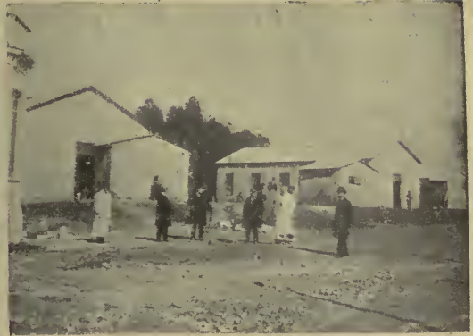
LOS PABELLONES QUE VAN Á DEMOLERSE, CONSTRUÍDOS EN 1886
