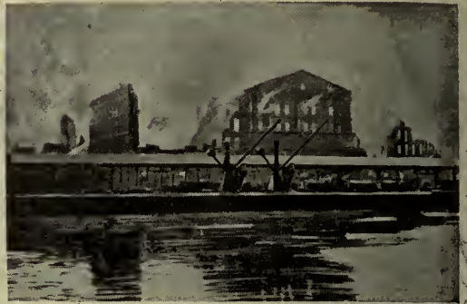
LA MISMA FACHADA DESPUÉS DEL INCENDIO
