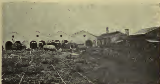
VISTA DE LOS TALLERES DEL FERROCARRIL DEL OESTE
