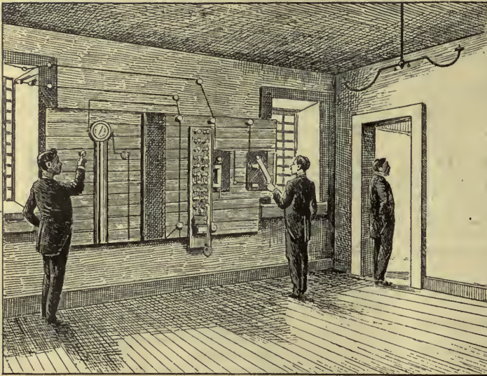
LA SALA DE LOS CONMUTADORES
