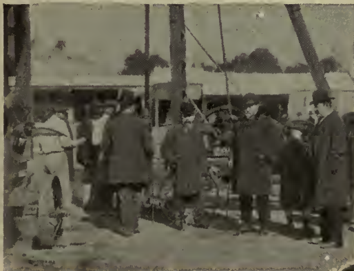
EL DOCTOR ESCALANTE PRESENCIANDO EL FUNCIONAMIENTO DE LA PERFORADORA
