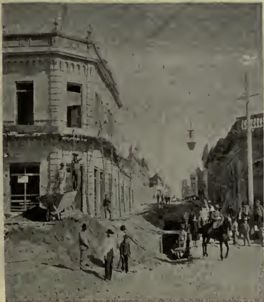
BOCA DEL TUNEL DE LOS DEBAQUES EN LA CALLE 24 DE SETIEMBRE
