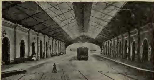
INTERIOR DE LA ESTACIÓN DEL OESTE
