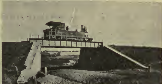
VIADUCTO ONCE DE SEPTIEMBRE
