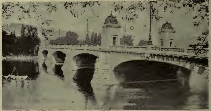
EL PUENTE FRANCISCO JOSÉ
