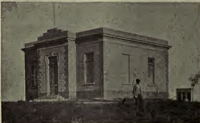
EXTERIOR DEL EDIFICIO DE LA NUEVA ESCUELA
