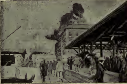
VISTA TOMADA DESDE EL INTERIOR DE LOS PATIOS
