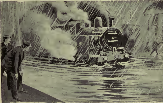
INUNDACIÓN DE UN TÚNEL DEL FERROCARRIL SUBTERRÁNEO
