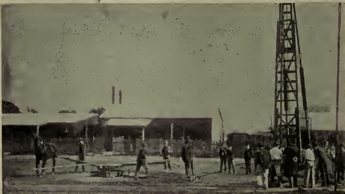
MÁQUINA PERFORADORA CON SU MALACATE
