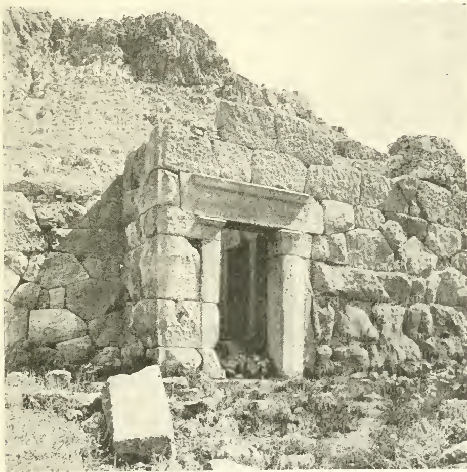
FIG. 4. — Edificio nell'acropoli di Cefalù.
