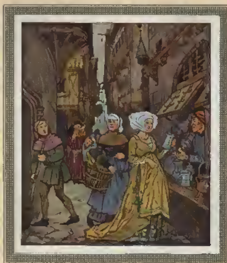
BILD 2: ENGE GASSE. Die mittelalterlichen Straßen waren enge, lichtarme Gassen zwischen hohen Fachwerkhäusern mit vorspringenden Geschossen und Erkern. Hier hatten die Handwerker ihre Verkaufsstände aufgeschlagen. Eine Tischplatte nebst Klappdach vor dem Werkstattfenster war der Laden der damaligen Zeit. Überall lagen Abfälle und Unrat, so daß die Straßen oft schwer begehbar waren.
