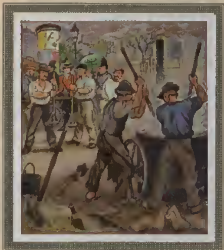
BILD 288: ASPHALTARBEITER. Die alten Germanen stellten die Wege aus Bohlen und Knüppeln her, was dem wald- und moorsreichen Lande entsprach. Später genigte zunächst auch noch ein Feldsteinpflaster. Der wachsende Verkehr verlangte bessere Verkehrswege. Das neue Reich baut große Autostraßen, die das Land wie ein Netz durchziehen, und den Ansprüchen eines raschen, dichten Verkehrs zu genügen.
