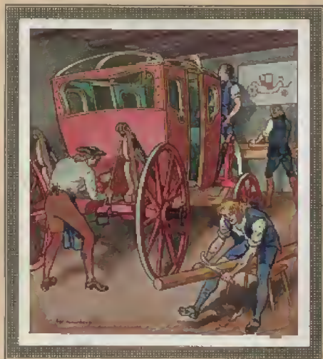
BILD 121: STELLMACHEREI. Der Stellmacher, der in Süddeutschland auch Wagner heißt, fertigte alle aus Holz gearbeiteten Teile des Wagens und oft auch diesen selbst an. Die Wagen hatten damals noch keine Federung, sondern waren in Ledergurten an hölzernen Haltern aufgehängt. Der schlechte Zustand der steinigen Straßen und das holprige Pflaster der Städte machten oft eine Wagenreparatur notwendig.
