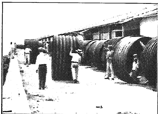
Fig. 1. — Arrivée à la Douane de Matanzas des tronçons de tuyaux ondulés fabriqués en France.
