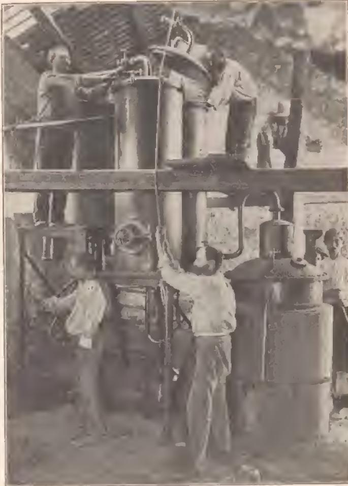
Fig. 30. Dampf-Destillierapparat für Rosmarinöl auf der Insel Lesina.
