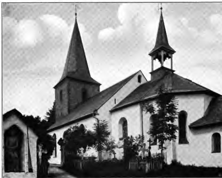
Südostansicht der Kirche.
