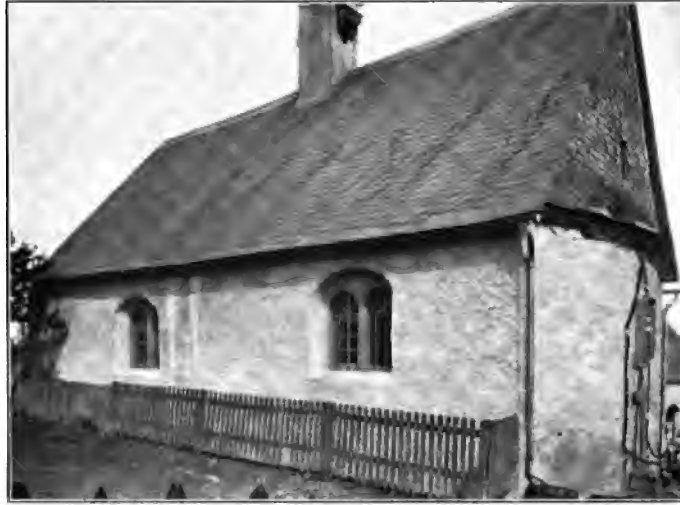
Südostansicht der Kapelle.
