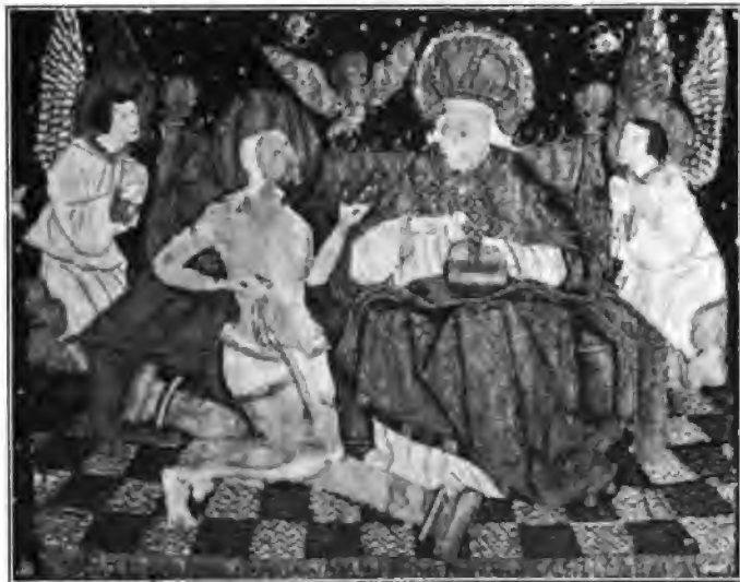
Details des Interpendiums in der Kirche zu Oehlinghausen.
