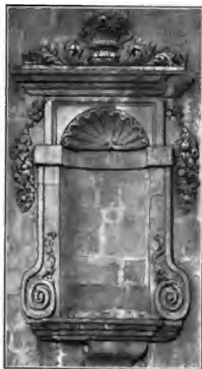
Detail der Westseite.
