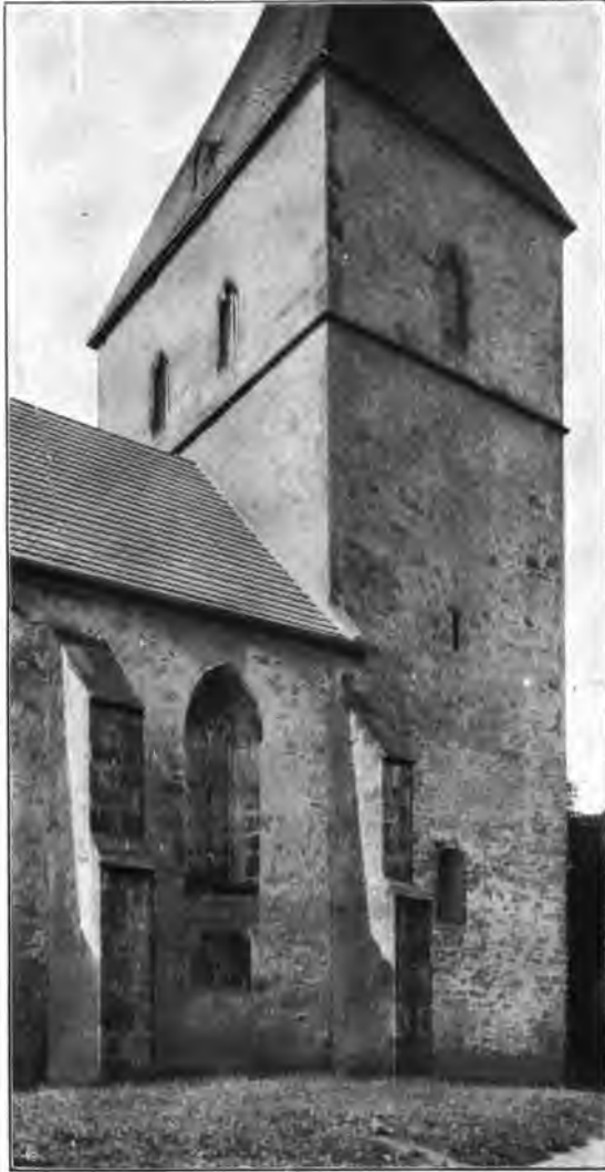
Nordostansicht des Thurmes.
