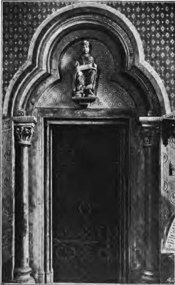
Fig. 17. Brauweiler. Portal im nördlichen Seitenchörchen.
