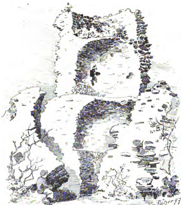
Fig. 68. Todtenfeld. Tomburg, Ansicht des gesprengten Bergfrieds.
