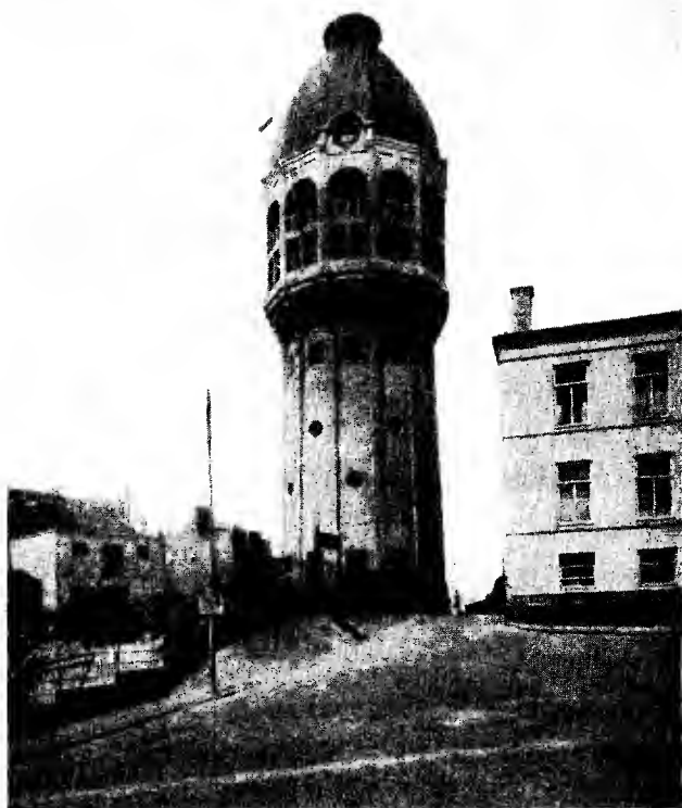
WATER- EN UITZICHTTOREN
