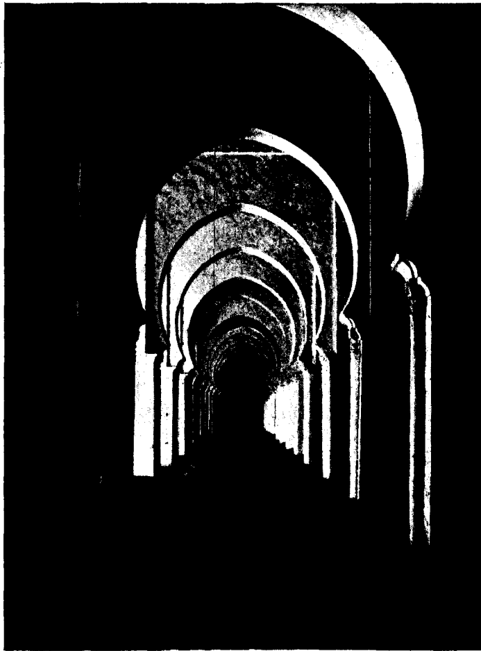
Fig. 74. — Oratoire de la Kotobtya : une travée.
