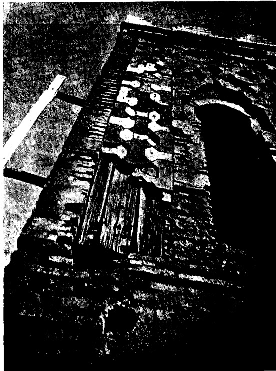
Fig. 117. — Minaret de la Qaşba : Mode d'attache des faïences du lanternon.
