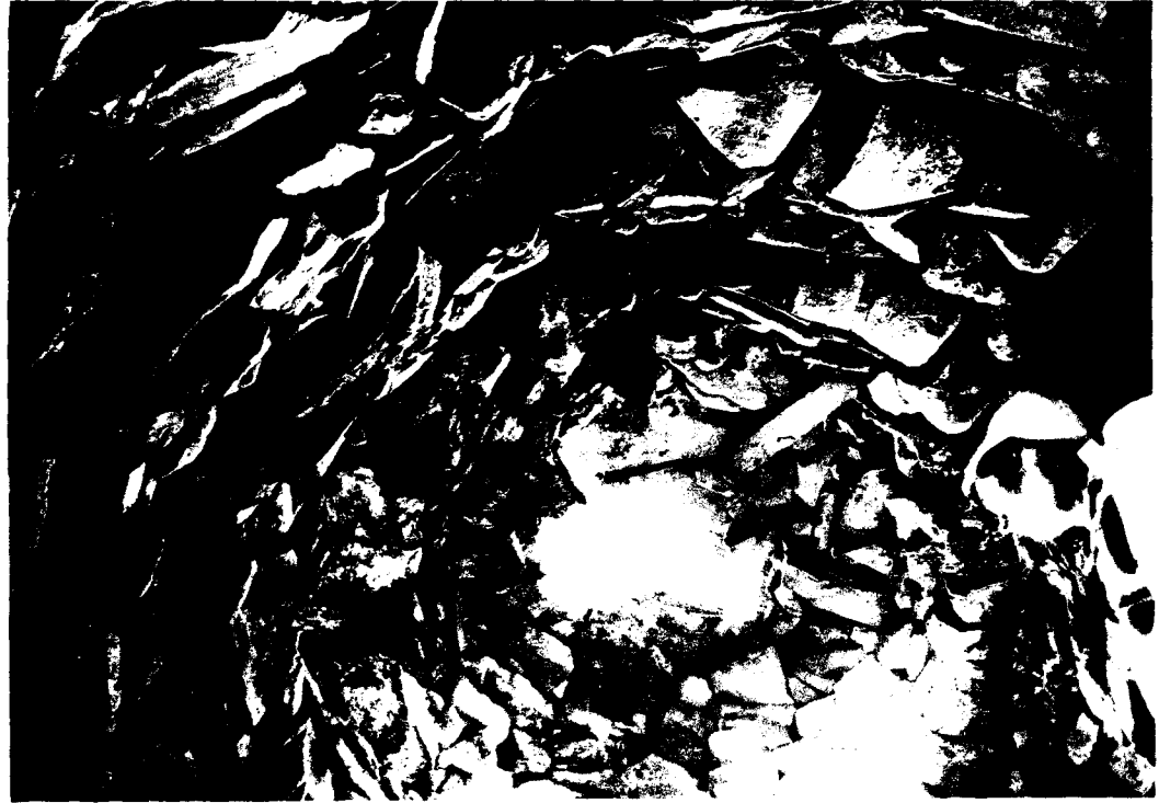
b. — Disposition en encorbellement dans une construction de plan circulaire.
