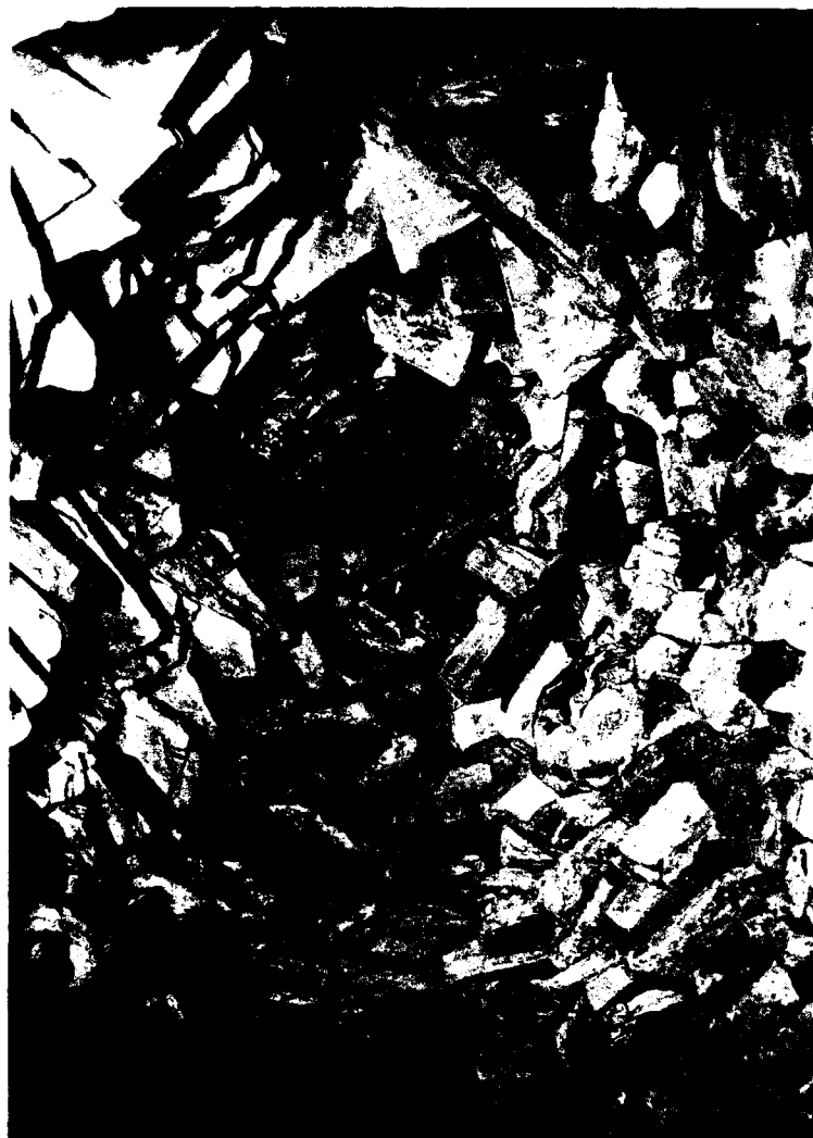
b. — Disposition en encorbellement dans une construction de plan circulaire D. 17.
