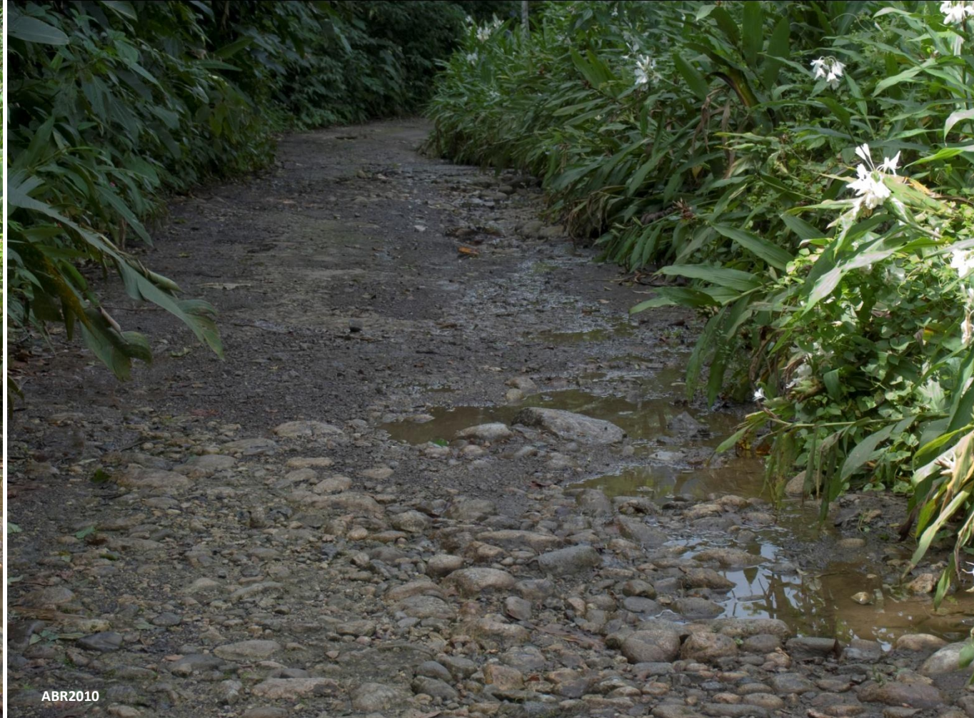
FIGURA 122. Trecho de subida mostrando os restos do recobrimento de concreto nos 6.100.
