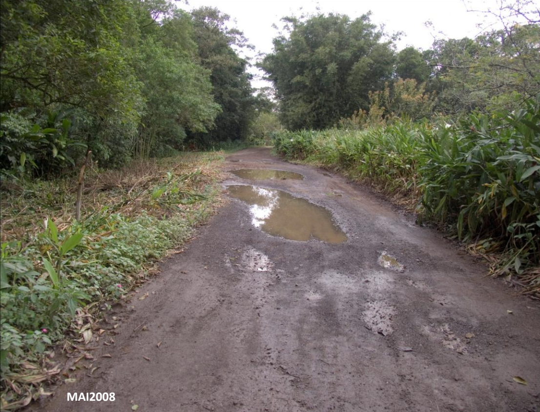
FIGURA 73. Aspecto da estrada no trecho 2300 – 2400 m mostrando o corte da borda do lado esquerdo (A) e do lado direito (B).
