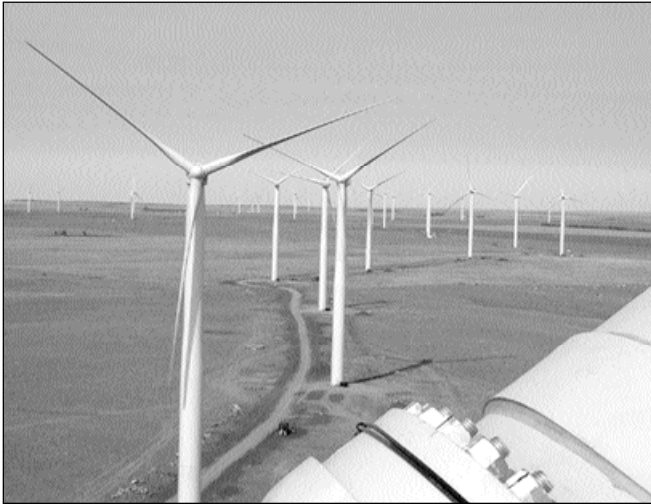
Parc d'éoliennes du type CE 1,5 MW en milieu agricole
