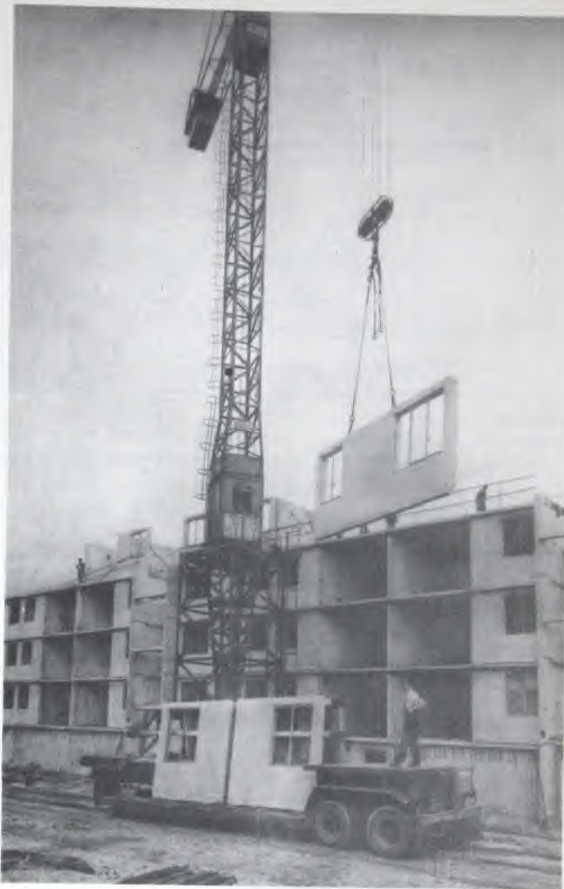
Fig. 22 - Au chantier, la grue appréhende le panneau sur sa remorque et le met directement à sa place définitive dans le bâtiment.
