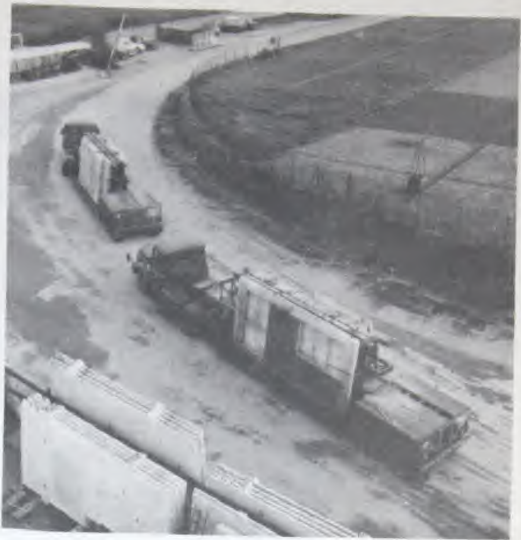
Fig. 15 - Le départ de l'usine pour le chantier. Même sans parler de ceux qui furent desservis par voie d'eau, de très nombreux chantiers desservis par route étaient distants de plus de 50 kms de l'usine.
