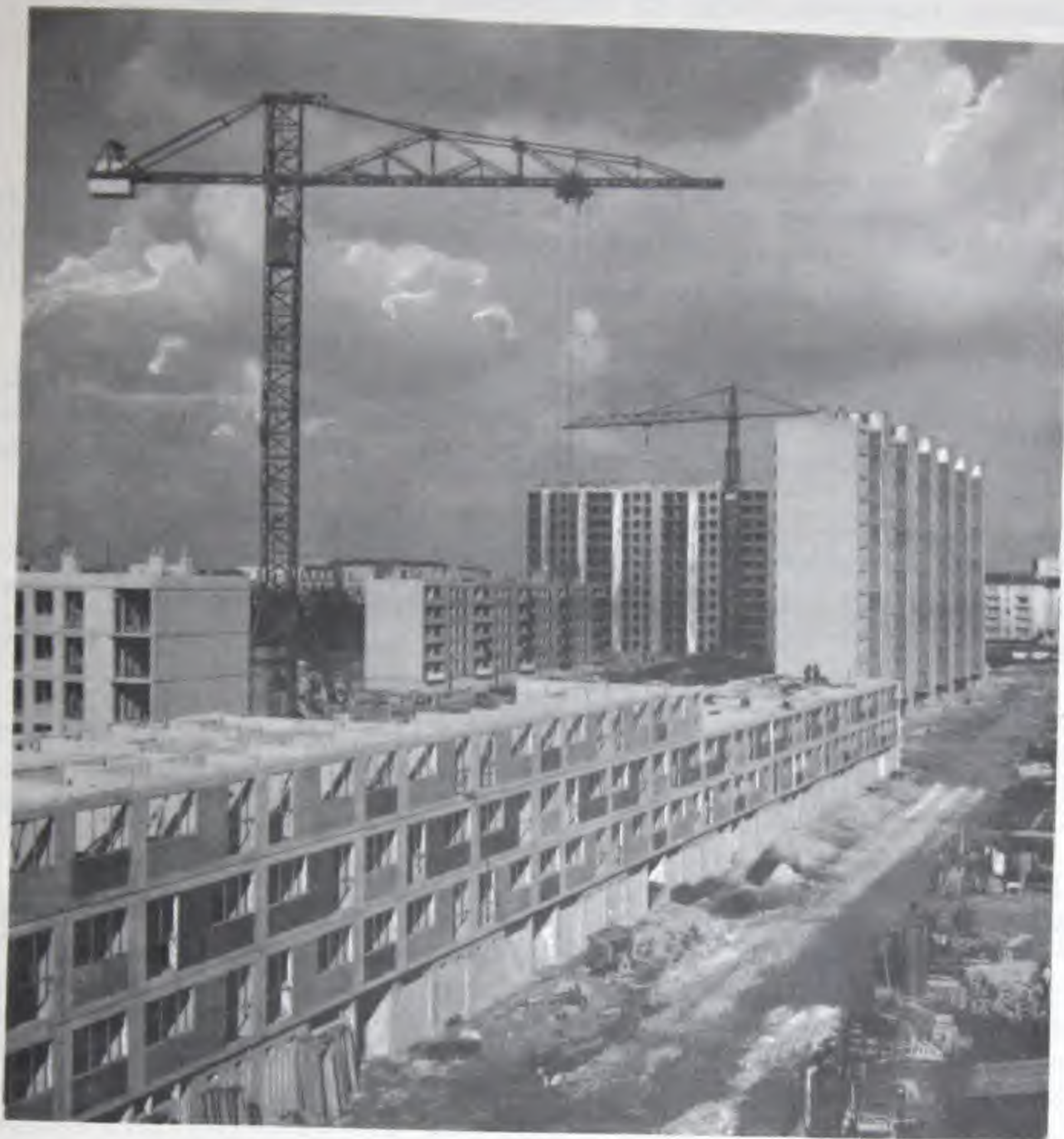
Fig. 18 - Vue générale d'un chantier en cours de construction. - Maisons-Alfort près de Paris - Société SERPEC - Licence CAMUS.
