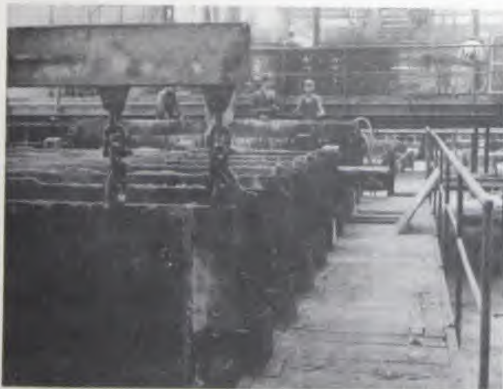
Fig.2 - Les panneaux les plus simples sont moulés dans des batteries de moules verticaux métalliques dénommés "banches". La figure montre une de ces batteries de banches au repos (c'est à dire après décoffrage et enlèvement des panneaux fabriqués).
