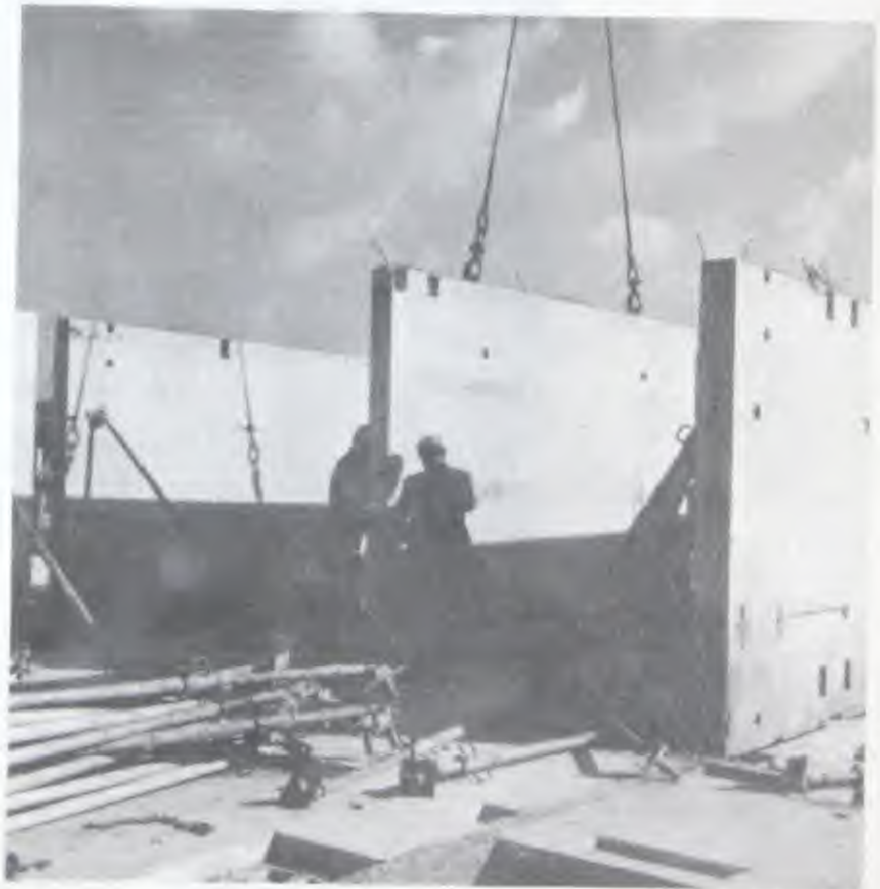
Fig. 16 et 17 - La mise en place d'un panneau au chantier. Sur la figure de droite, on voit au premier plan les systèmes d'étaie-ment.
