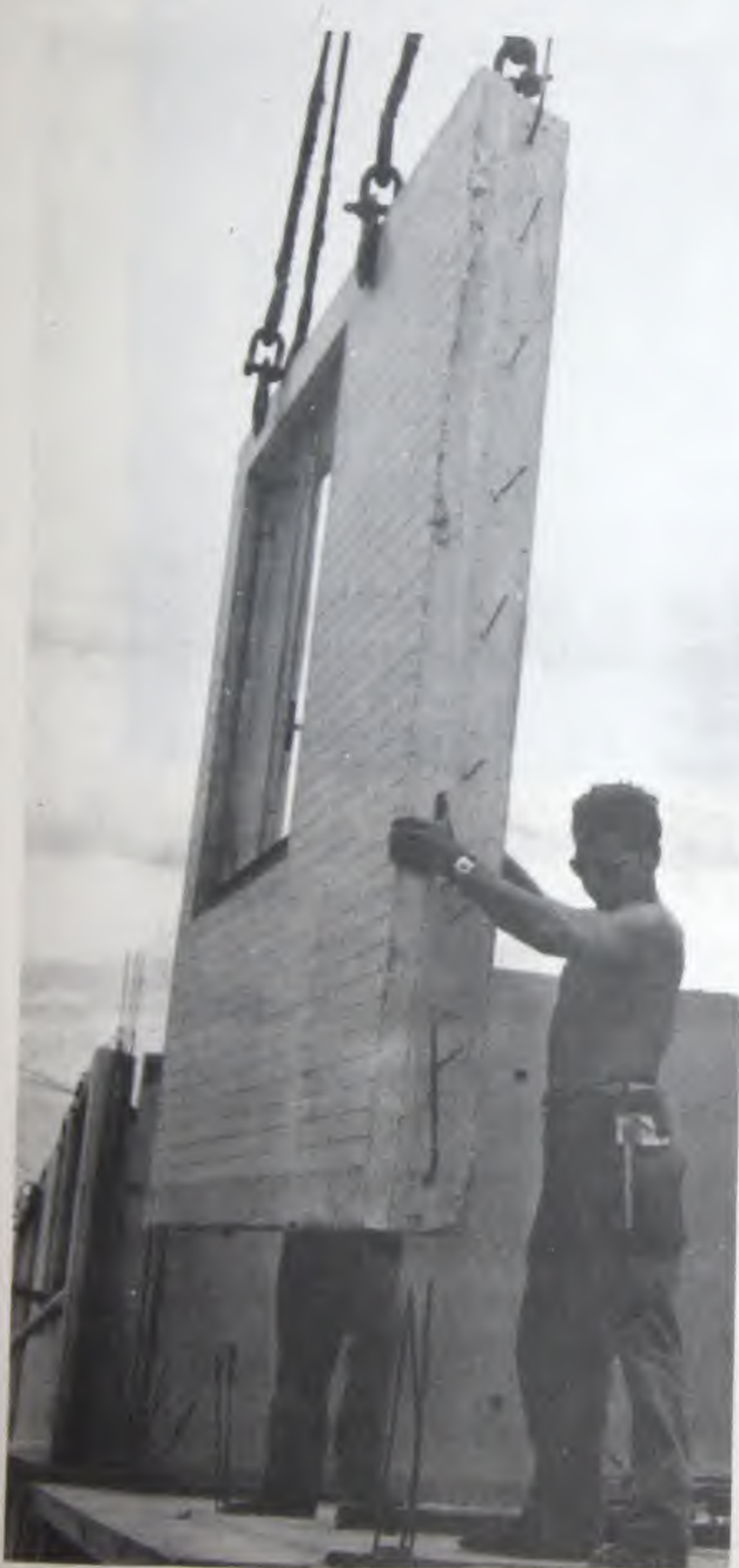
Fig. 16 et 17 - La mise en place d'un panneau au chantier. Sur la figure de droite, on voit au premier plan les systèmes d'étaie-ment.
