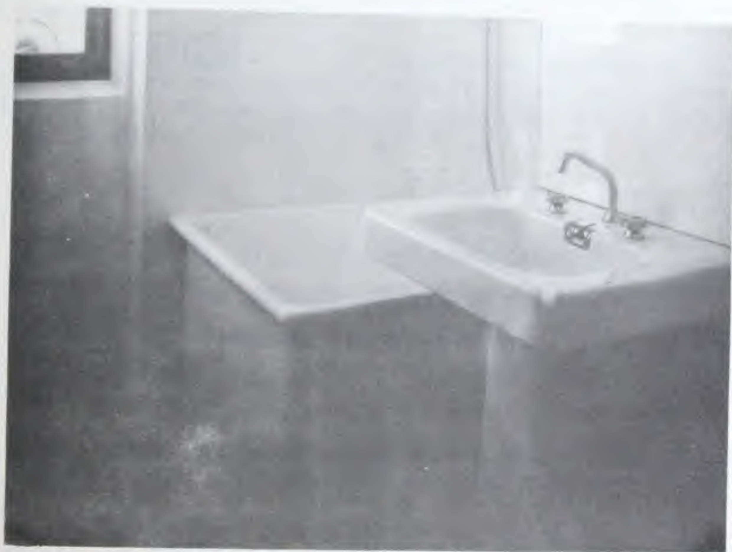
Fig. 37 et 38 - Un exemple de finition : l'intérieur du logement type LOGIREX.
