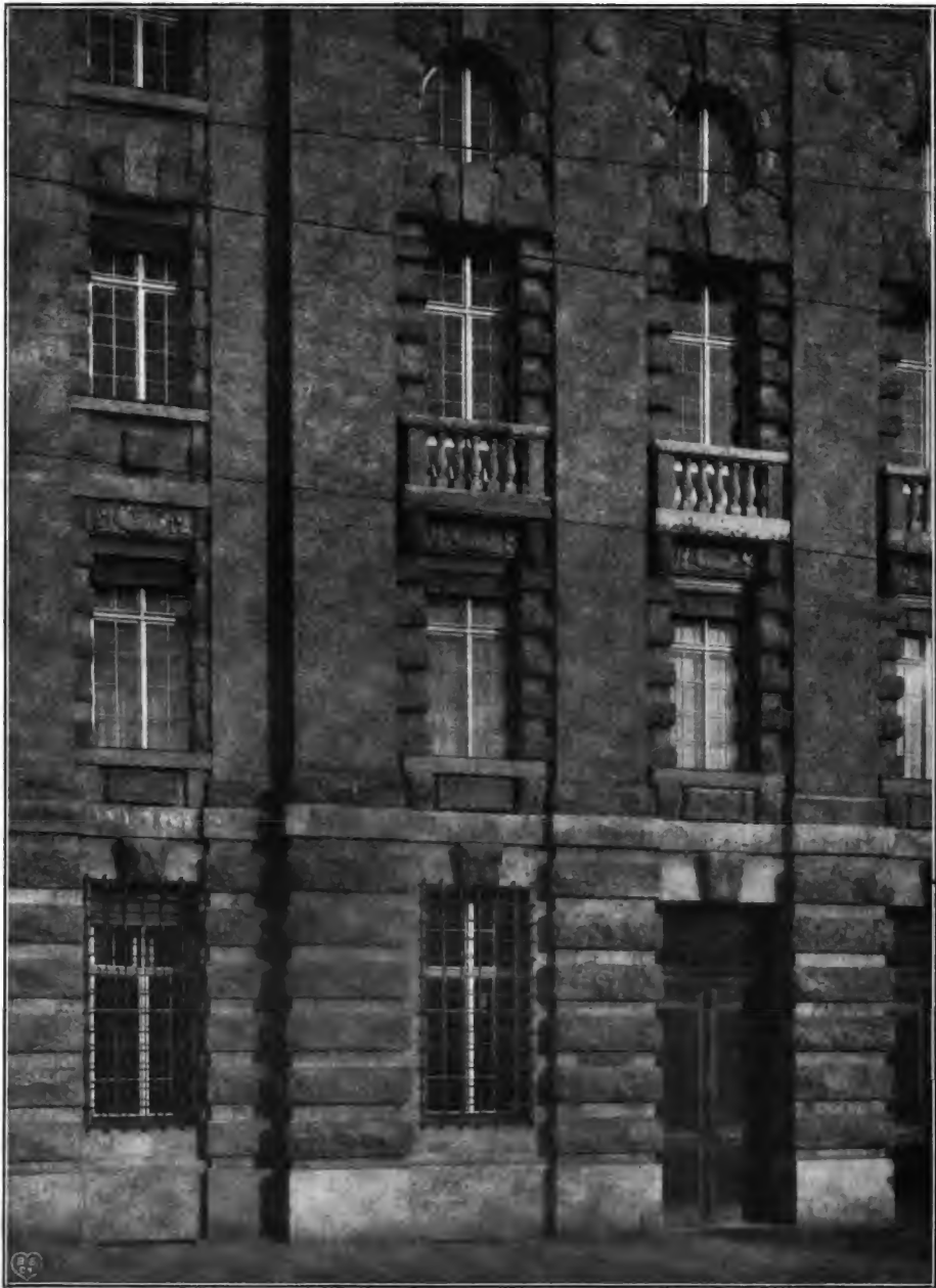
Detail der Front des Verwaltungsgebäudes der Allgemeinen Elektrizitätsgesellschaft
