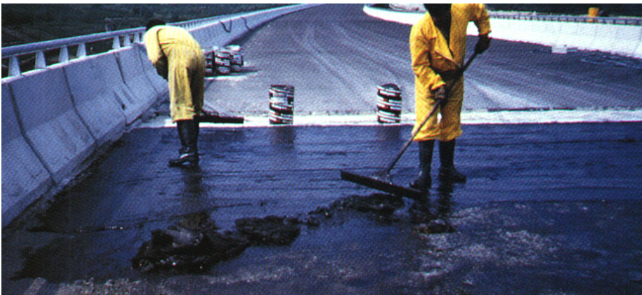
Fig. 21.1 – Extendido de una capa de mortero con betún fluidificado
