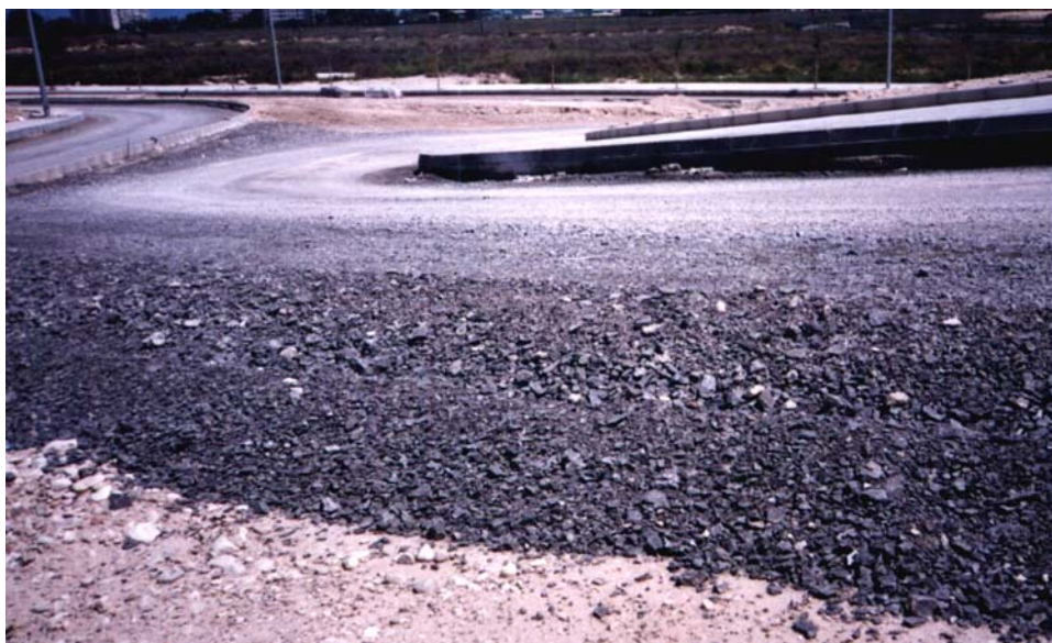
Fig. 19.3 – Aspecto de la capa de base puesta en obra
