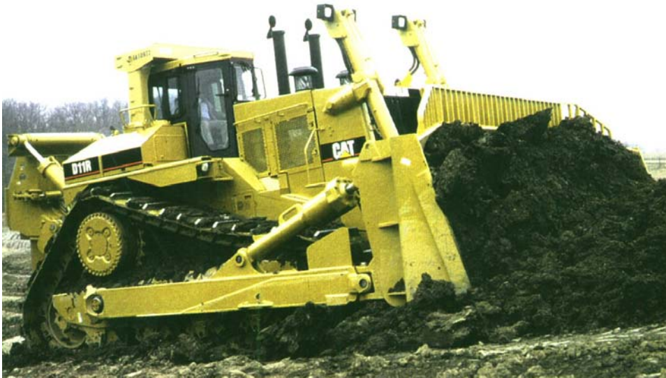
Fig. 16.3 – Bulldozer efectuando labores de excavación y escarificado
