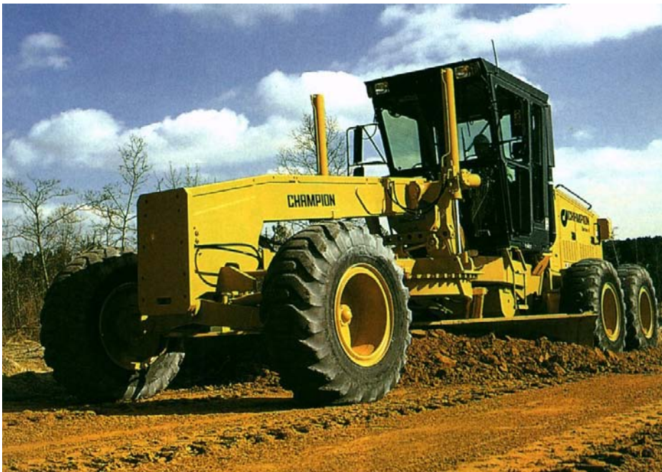
Fig. 16.7 – Motoniveladora perfilando la explanada mejorada
