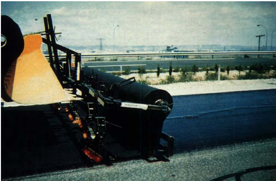
Fig. 21.3 – Extensión de una membrana SAMI para un tratamiento antifisuras
