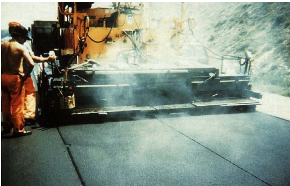
Fig. 19.2 – Extensión de una capa de slurry sobre un firme en servicio
