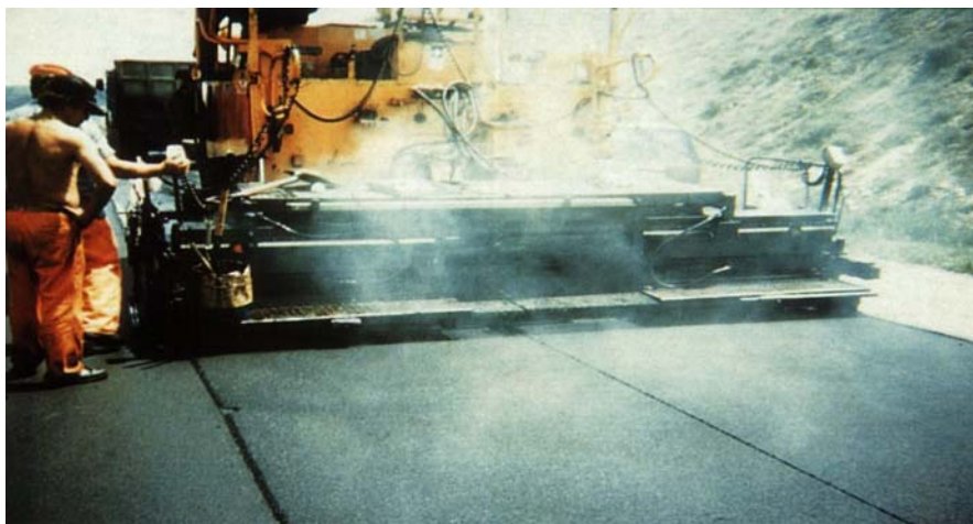
Fig. 23.4 – Puesta en obra de una capa de lechada bituminosa
