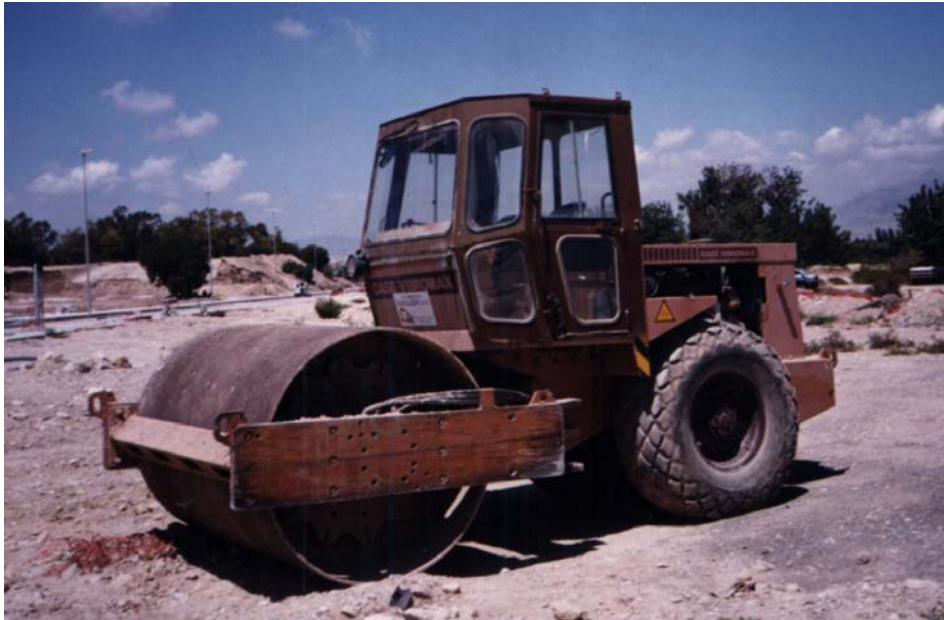
Fig. 22.9 – Compactador vibratorio empleado en capas granulares
