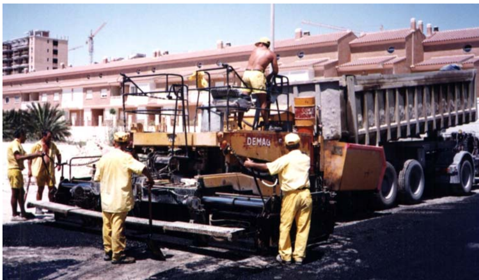
Fig. 23.7 – Proceso de carga de una extendidora
