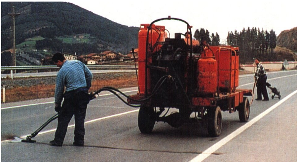
Fig. 25.12 – Operario efectuando labores de conservación en un firme
