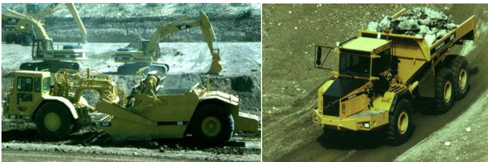
Fig. 16.4 – Maquinaria empleada en el transporte y extendido de tierras
