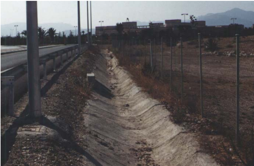
Fig. 18.1 – La cuneta es el elemento de drenaje longitudinal por excelencia
