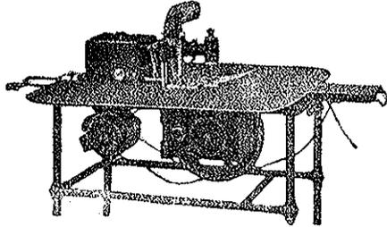
Die Maschine repetiert wie jede andere Adressiermaschine, druckt auch auf Listen und Streifen und liefert einen tadellosen sauberen Buchdruck. Sie arbeitet mit Hand- oder elektrischem Antrieb.
