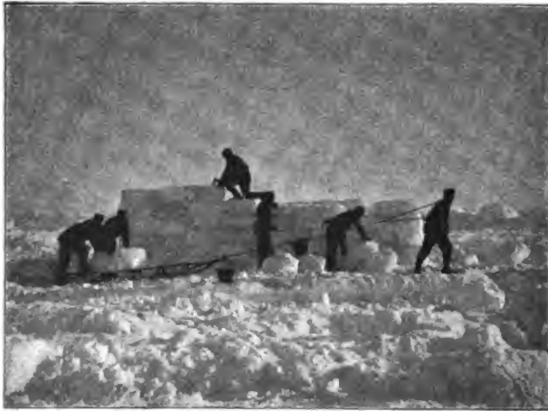
Bau des ersten magnetischen Variationshauses.
