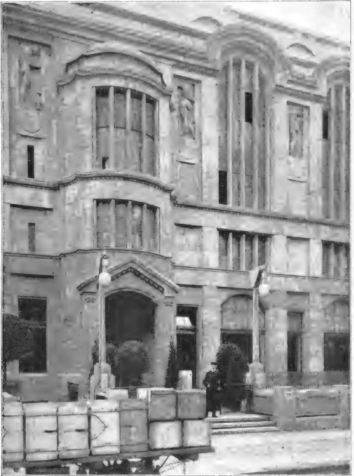
Prof. Bruno Schmitz: Haus Rheingold Berlin: Detail der Fassade Bellevuestr. (Zum Artikel v. J. A. Lutz.) Mit gütiger Erlaubnis des Verlages J. J. Arnd, Leipzig.
