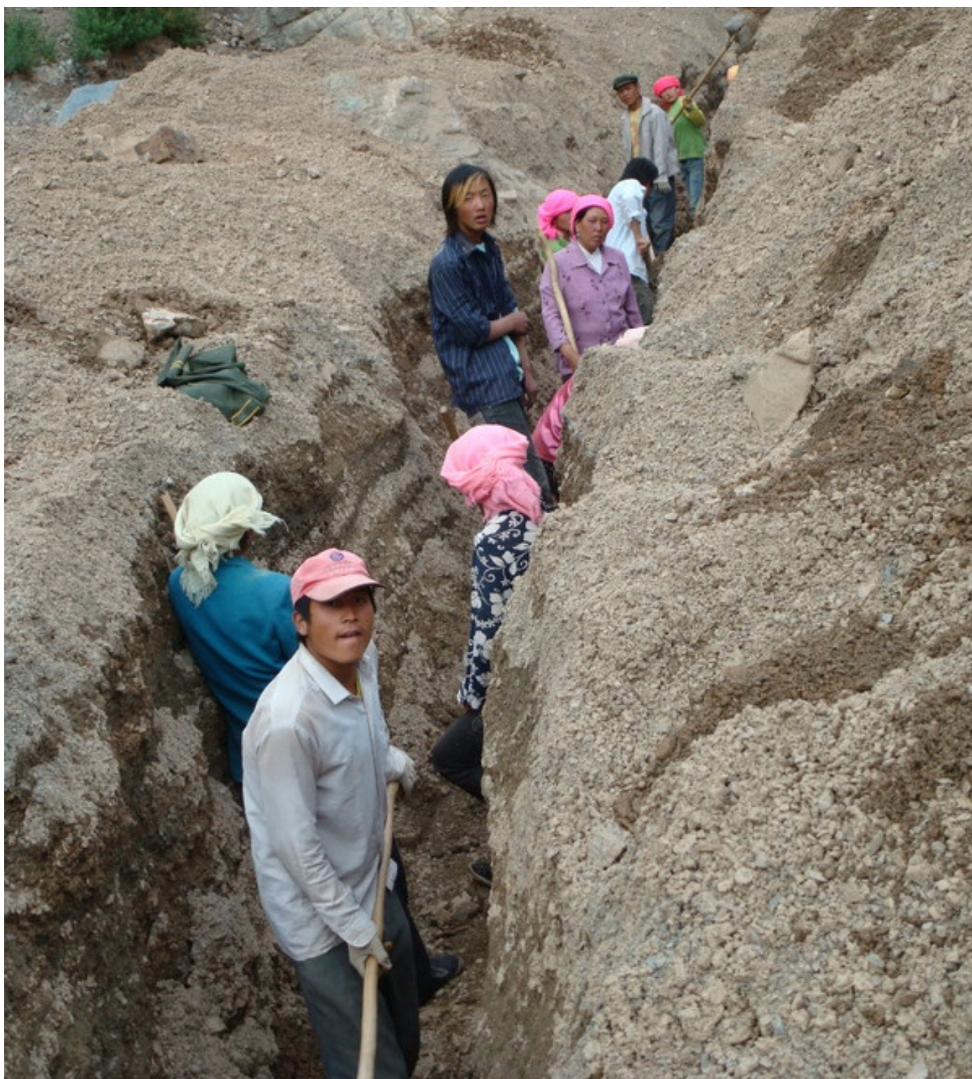
Mr. Pemo Zhaxi བཀའ་མོ་བཀྲ་ཤིས། (b. 1982), Ms. Cairang Cuo ཚེ་རིང་མཚོ། (b. 1967), and others dig the pipe ditch.
