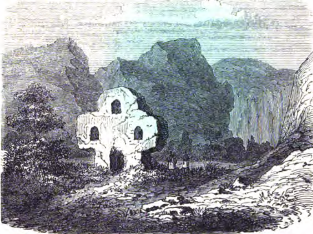
Felsenkirche von Gauazien. Nach Isenberg.
