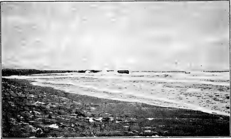
Sturmflut auf Baltrum gegen das Pallisadenwerk anschlagend.
