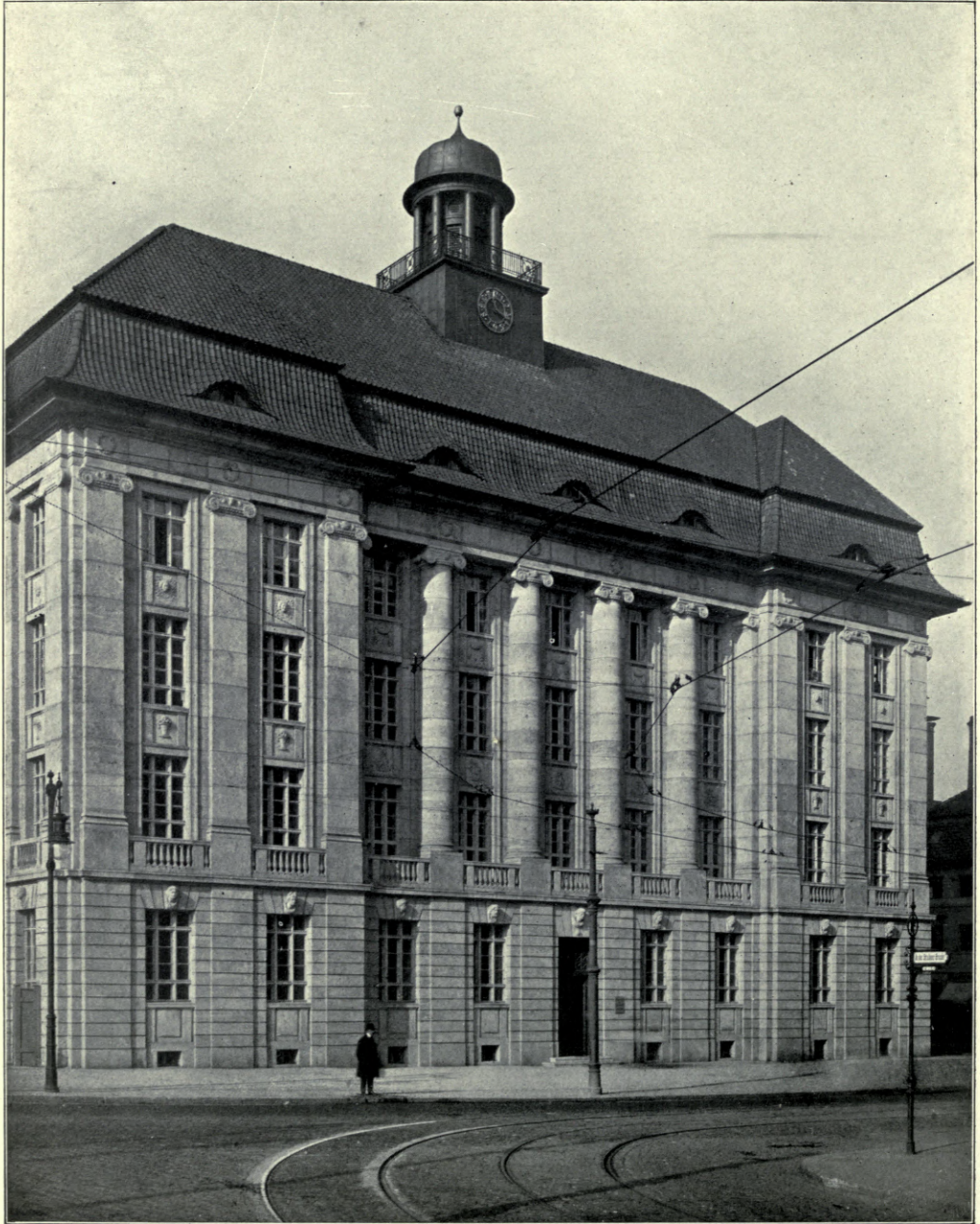
Offices of the City Gasworks, Waisenbrücke, Berlin. Stadtbaurat Geh. Baurat, HOFFMANN, Architekt.
