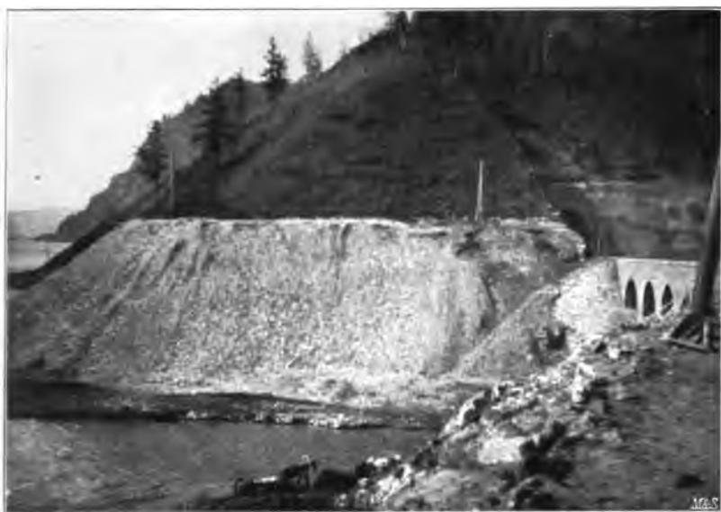
Tunnel der Baikal-Umgebungsbahn.
