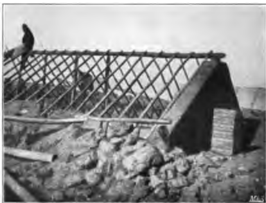
Erdbütte im Bau.
