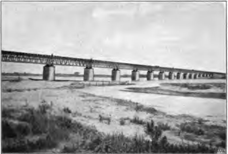
Eisenbahnbrücke über den Sun ho bei Mukden.
