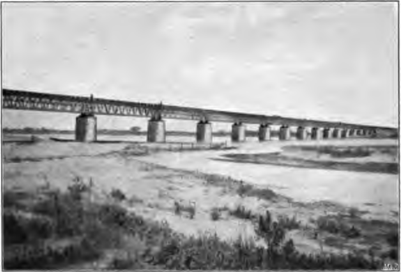
Eisenbahnbrücke über den Sun ho bei Mukden.
