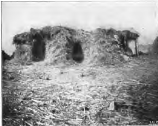
Mauerreste, durch Verkleidung mit Gaoßan und Dünger zur Unterkunft hergerichtet.
