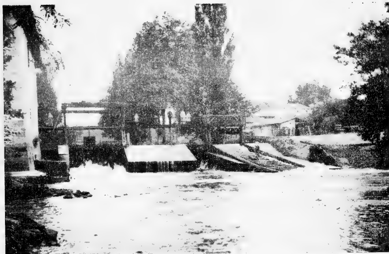
(Fig. 7) Rivière des Landes, navigable et flottable. Le Ciron à Villandraut (Gironde). Barrage avec Passelis, pour le flottage des trains de bois.
