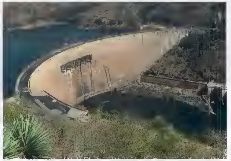
زيمبابويه: سدّ هاني لانتاج الكهرباء.
