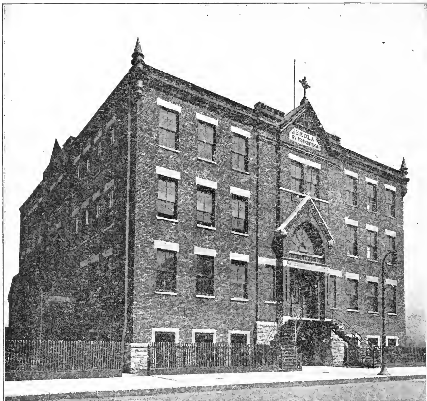
ŠKOLA SV. PROKOPA NA ALLPORT UL.
