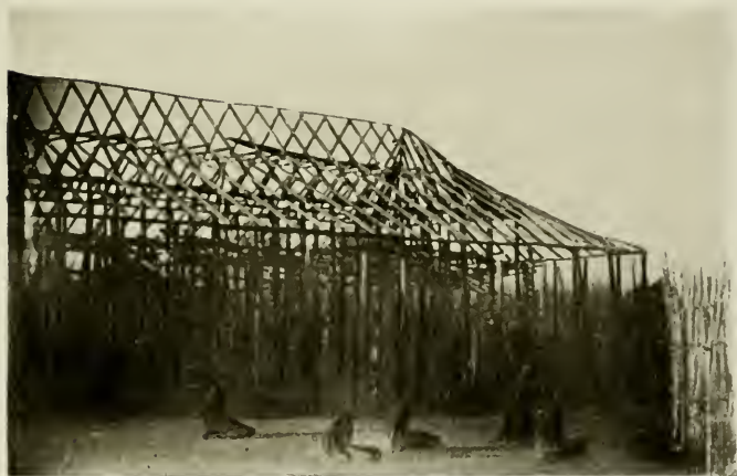
Framework of Akatoka’s House
