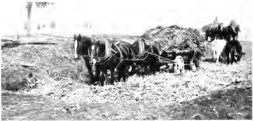
Filling a Pit Silo.
