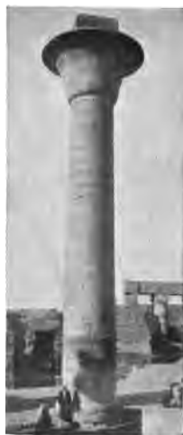
FIG. 125. — Column of Taharqa. Karnak.
