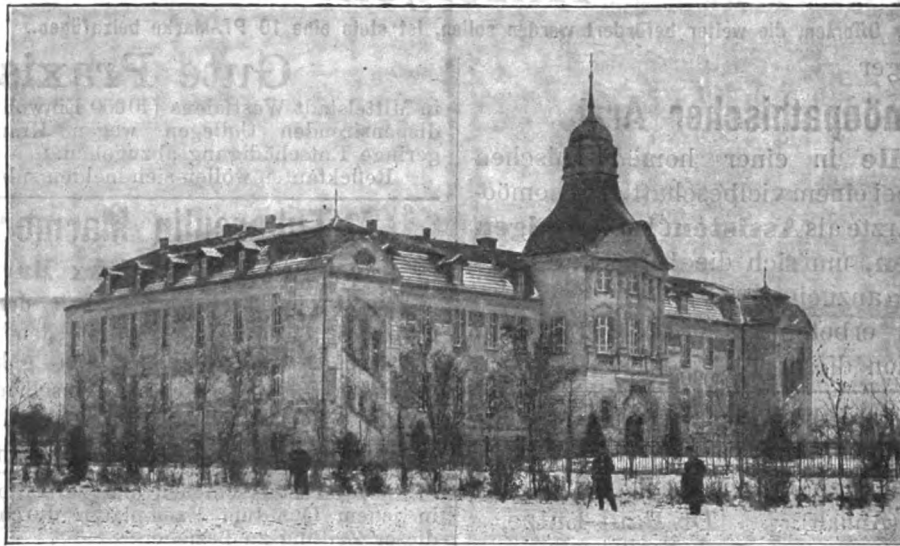
Berliner homöopathisches Krankenhaus Gross-Lichterfelde-West Carstenstrasse.
