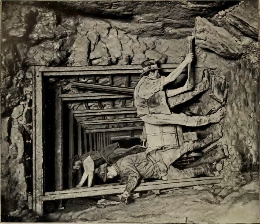
3. Eiserner Ausbau einer Förderstrecke. Wegfüllarbeit. Freiberg. Nach Photographie von H. Boerner in Halle a. S.
