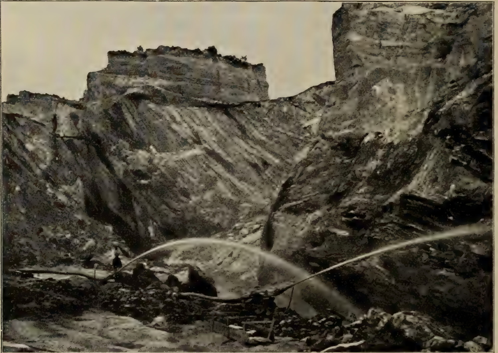
Hydraulische Goldgewinnung in den Stago-Goldfeldern auf Neuseeland. (Nach Photographie.) Vgl. Text, S. 317.
