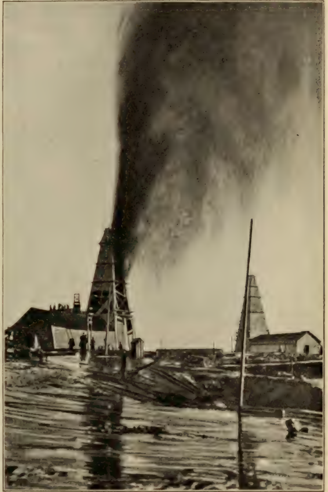
Bohrtürme und Explosion von Rohöl bei Baku. (Nach Photographie von A. Schmidt.) Engl. Zeit. S. 316.
