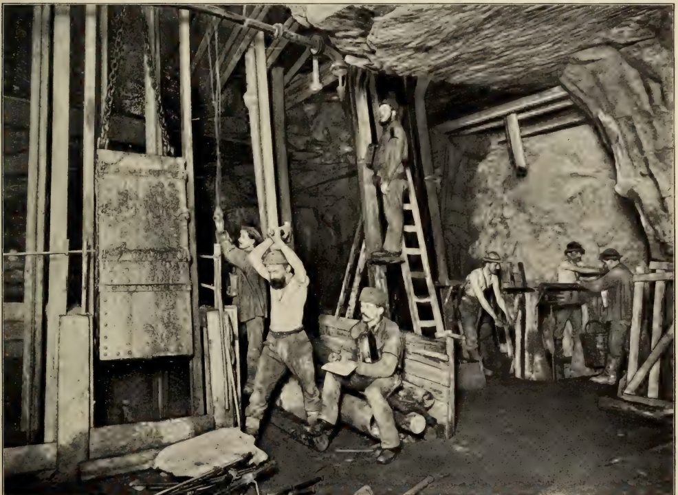
5. Schachttonnenförderung, Ausfahrt auf der Fahrkunst, Haspelziehen. Freiberg. Nach Photographie von H. Boerner in Halle a. S.
