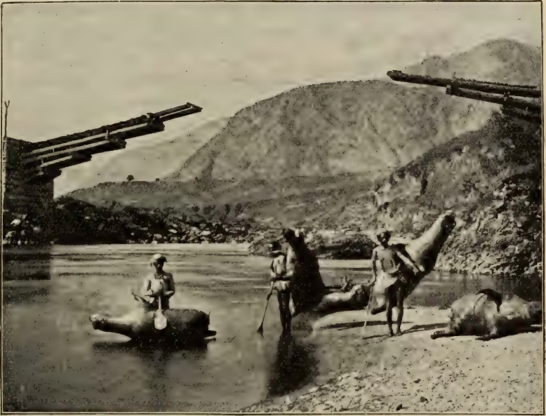
Aus Tierhäuten gefertigte, schwimmende Luftschläuche in Nordindien. (Nach Photographie.)
