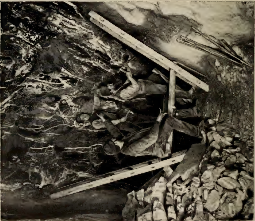
2. Abbau einer Erzlagerstätte (Fürstenbau). Herstellung der Sprengbohrlöcher. Oberharz. Nach Photographie von W. Zirkler jun. in Klausenthal.
