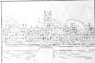
Les édifices du parlement du Canada, au lendemain de l'incendie.
