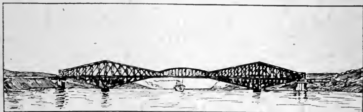
Le pont de Québec, tel qu'il paraîtra, quand il sera terminé.
