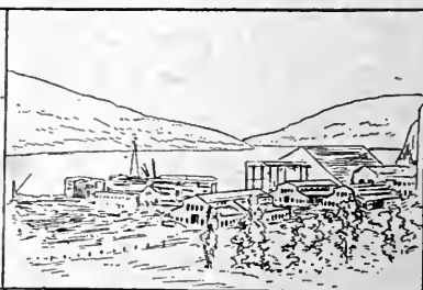
Bassin de radoub et installation du G.T.R., à Prince-Rupert, C.-B.
