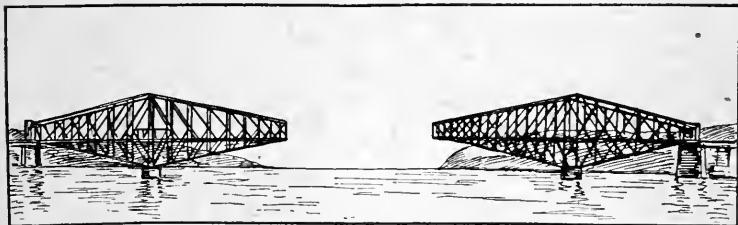
Le pont de Québec, tel qu'il est actuellement.
