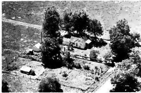
PATTERSON, H. K. Rt. 1-Tenant House
