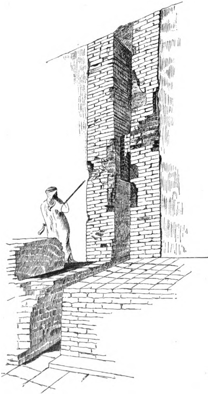
FIG. 15.—WATER CONDUIT ON THE S. W. FACE OF THE ZIGURAT.
