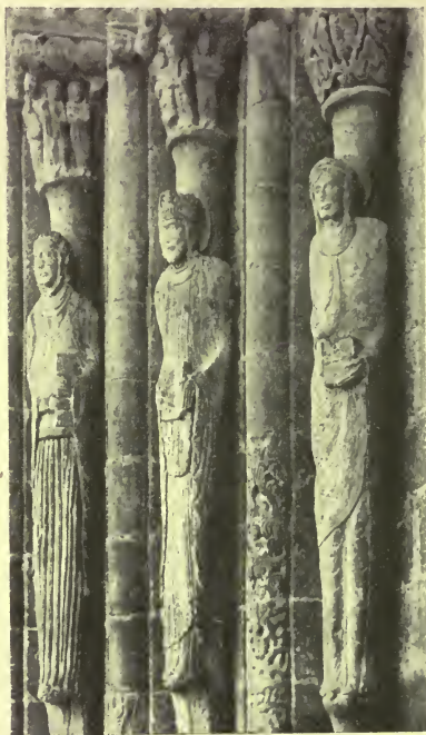
FIGURE 27.—WEST JAMB: SANTA MARIA LA REAL: SANÜGESA (NAVARRA).
