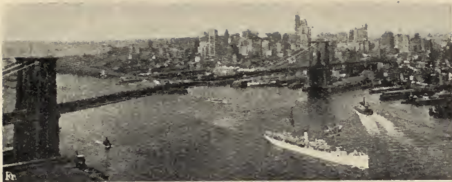
Brücke nach Brooklyn
