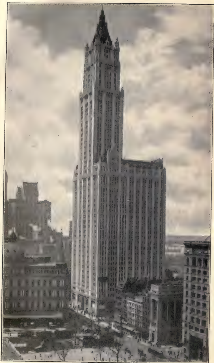
New Yorks höchster Wolkenkratzer Woolworth Building
