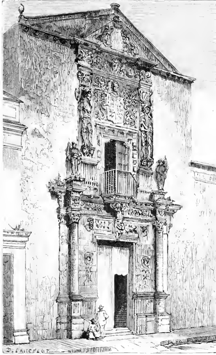
Casa de D. Francisco de Montejo (De fotografía)
