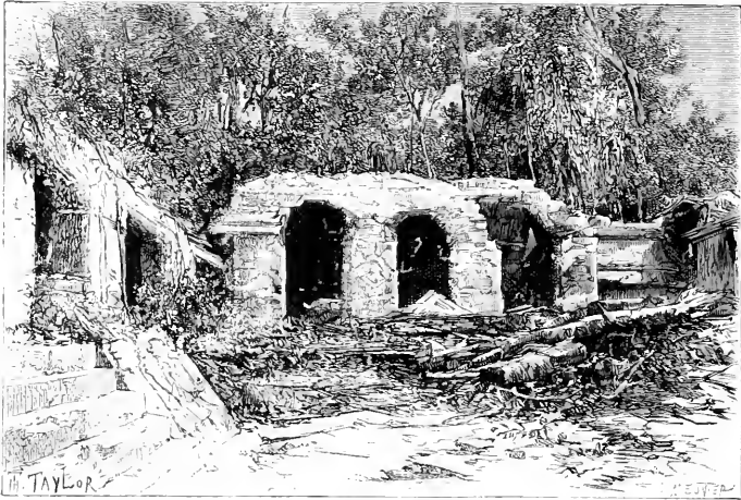
Pequeño edificio en el patio del palacio de Palenque (De fotografía)
