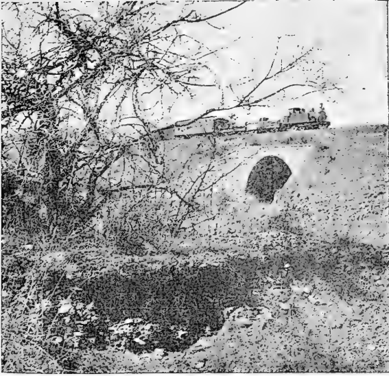
Fig. 13. — Salta : Alcantarilla en el Ferrocarril Central Norte
