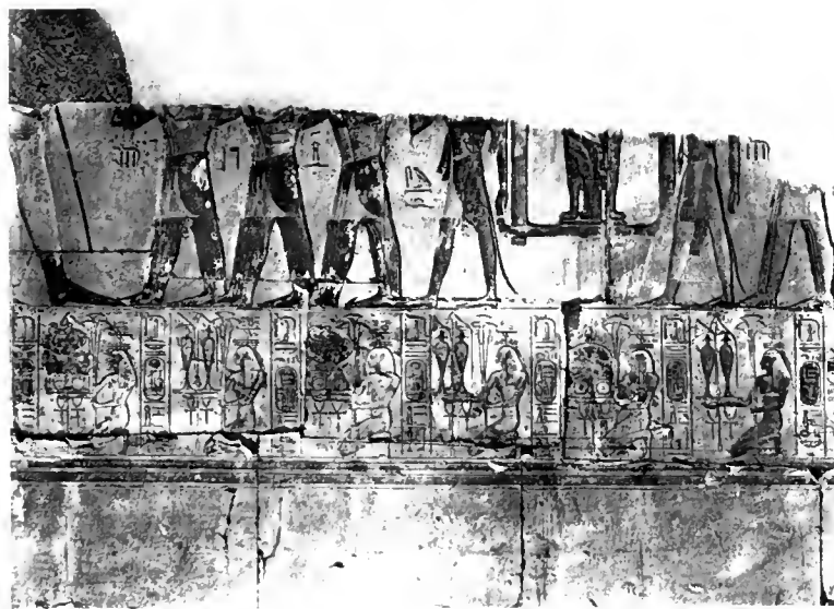
N° 2. — Après le nettoyage. Hypostyle B.
