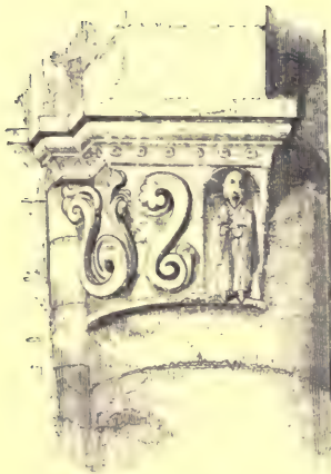
PIER IN THE NAVE, NOTRE DAME, ÉTAMPES.
