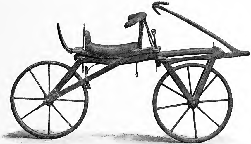
Laufmaschine (Draisine), konstruiert von Carl Freiherrn von Drais.
