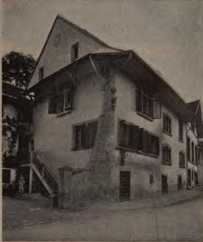
Fig. 7. Haus zum Salmen in Freiburg.
