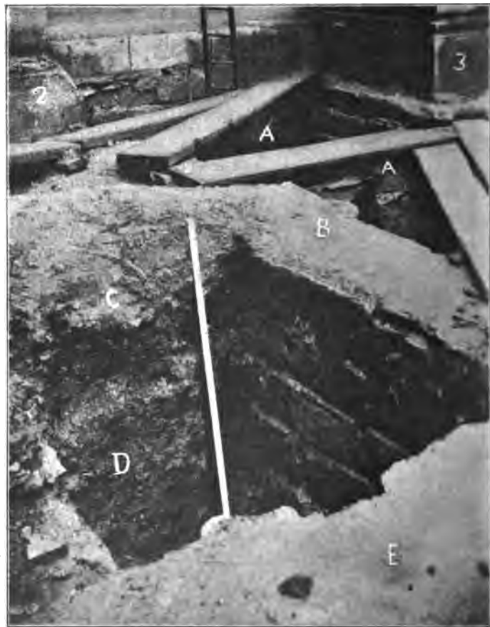
Fig. 62. A Galerie ouest du cloître dont les murs se soudent aux contreforts 2 et 3 de la cathédrale. — B Mur intérieur de ladite galerie. — C et D Couches d'incendies. — E Mur de l'époque bernoise. (Le C devrait être placé 15 mm plus bas sur le cliché)
