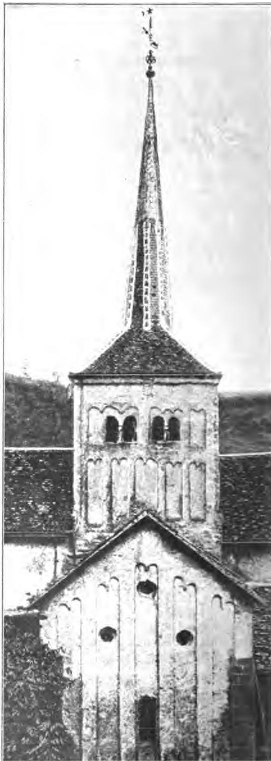
Fig. 100. Faces nord clocher et transept X e S. ; le clocher a été un peu surélevé. Noter les bandes murales et les baies.
