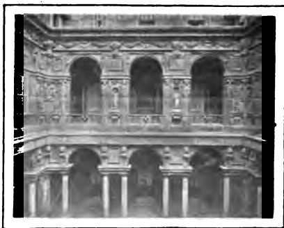
FIG. 224. MILANO: CORTILE DEL PALAZZO MARINO.
