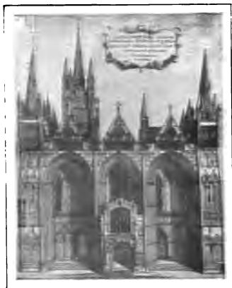
FIG. 170. — CATTEDRALE DI PETERBOROUGH (FACCIATA OVEST).
