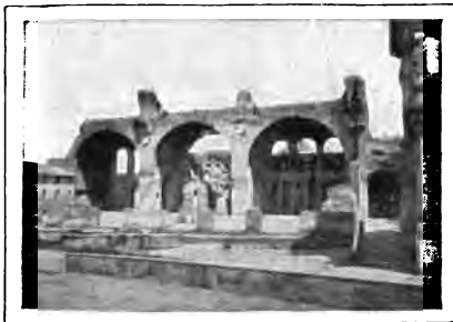
FIG. 124. — RUINE DELLA BASILICA DI COSTANTINO A ROMA.
