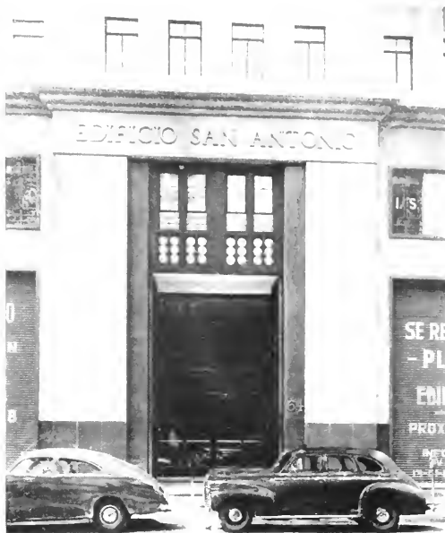
MAIN ENTRANCE of the Edificio San Antonio.
