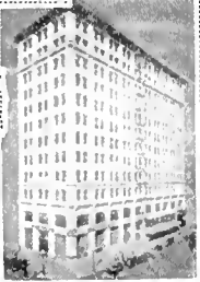
HAAS BLDG. LOS ANGELES, CAL.
