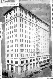
HAAS BLDG. LOS ANGELES CAL.
