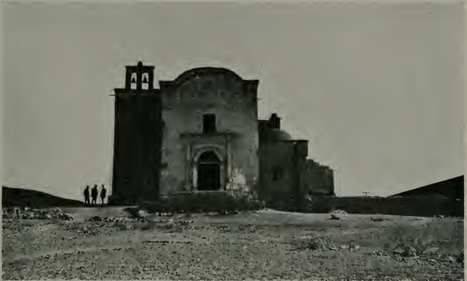
FACADE, SAN ANTONIO DEL PITIQUITO
